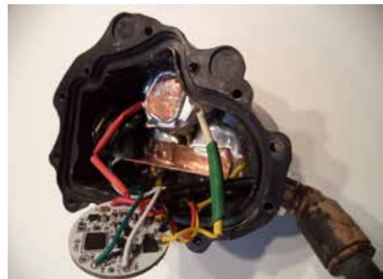
Foto 8: Aansluiten van de dualflex
